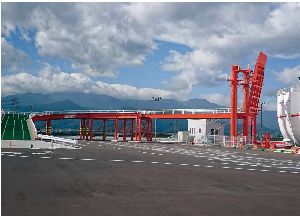
東予港サイドランプ Side ramp for carry vehicles at Port of Toyo
