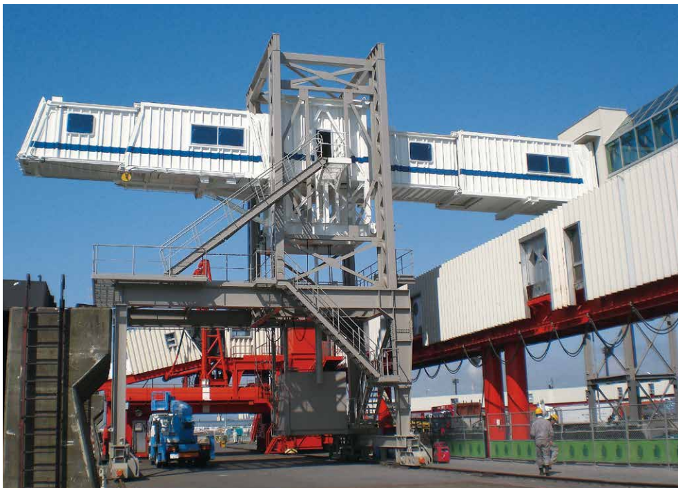
苫小牧港人道橋(ギャングウェイ装置) Passenger boarding bridge at Port of Tomakomai (Gangway system)
