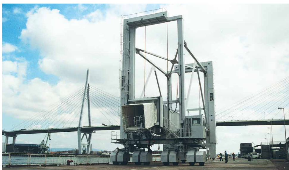
移動中のギャングウェイ装置 Gangway system under moving
