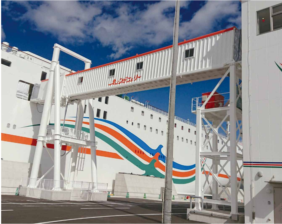
東予港人道橋(ギャングウェイ装置) Passenger boarding bridge at Port of Toyo (Gangway system)
