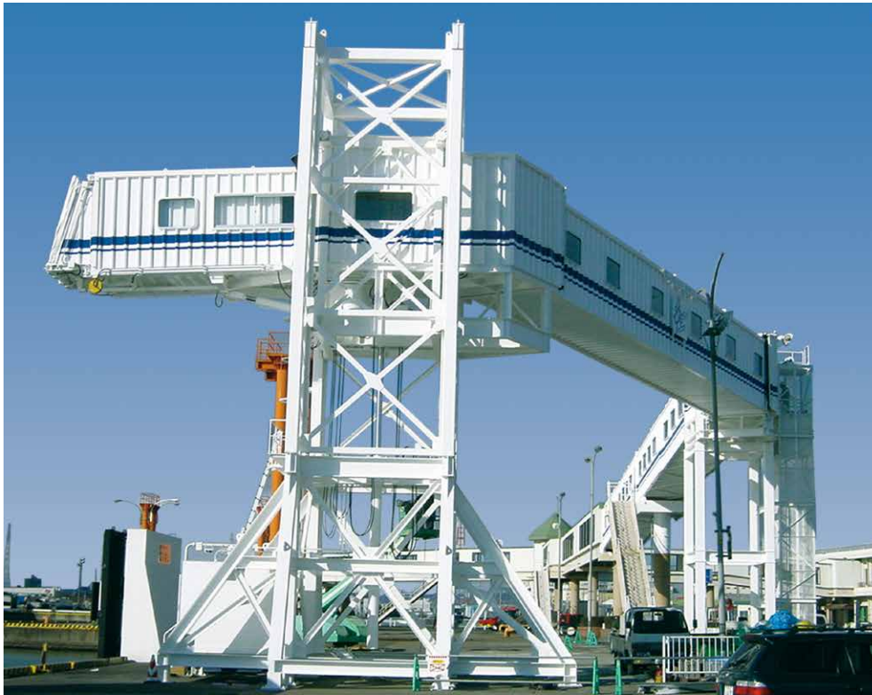
仙台港人道橋(ギャングウェイ装置) Passenger boarding bridge at Port of Sendai (Gangway system)
